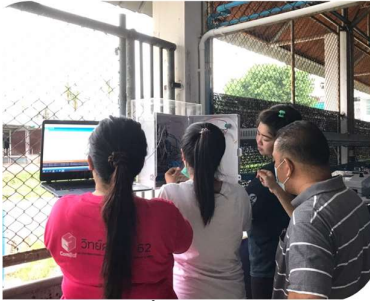
รูปที่ 8 ติดตั้งตู้ระบบควบคุม
